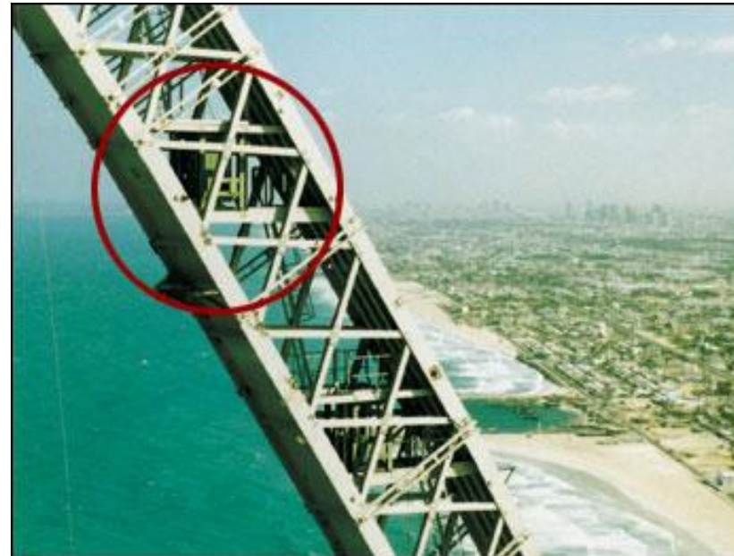
Tilger im Stahlrahmen eingebaut
